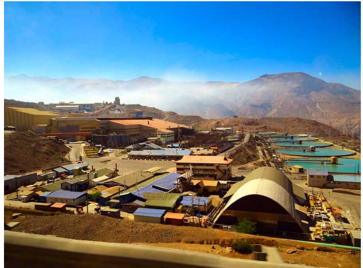
Das Konzentratorkwerk Colón für das Kupferbergwerk El Teniente in Chile mit den Hallen der Steinbrecher und Förderbänder hinten, unten die Erzmöhlen, in der Mitte die Halle der Flotationsanlage und rechts davon Kläranlagen. In El Teniente wird die größte bekannte Kupferlagerstätte mit einem Inventar von 92,1 Megatonnen Kupfer abgebaut. Dafür wurden bisher mehr als 3000 Kilometer Strecken vorgetrieben. Die Grube liegt in einem erloschenen Vulkan in den Anden. Der Erzabbau erfolgt von unterhalb der Lagerstätte durch Absenken des höherliegenden Gesteins.
